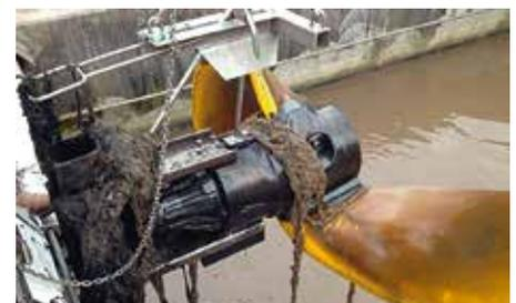
Verzopfungen an einem Rührwerk Verbandskläranlage Bruck
